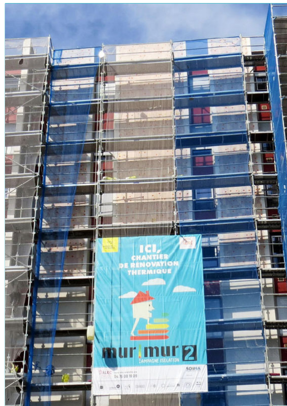
Mur|Murにより改修中の建物
