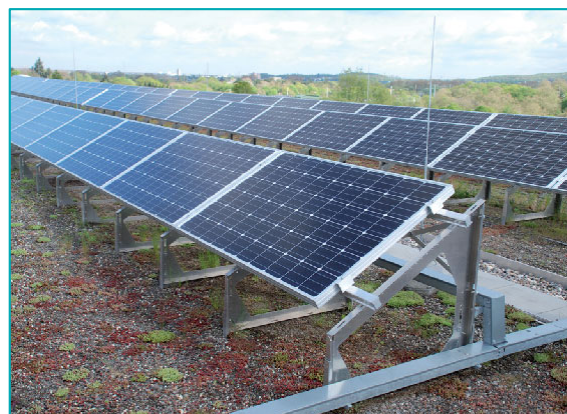
環境省の屋上にグリーンルーフと太陽光発電パネルを組み合わせ設置
