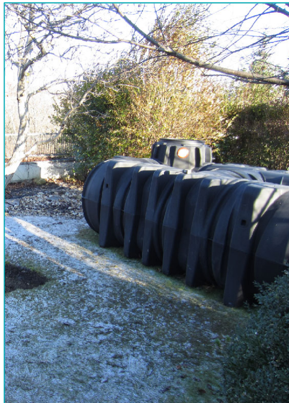
土に埋められる前の雨水貯留槽
